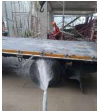
รูปที่ 9 ล้างล้อรถบรรทุก
